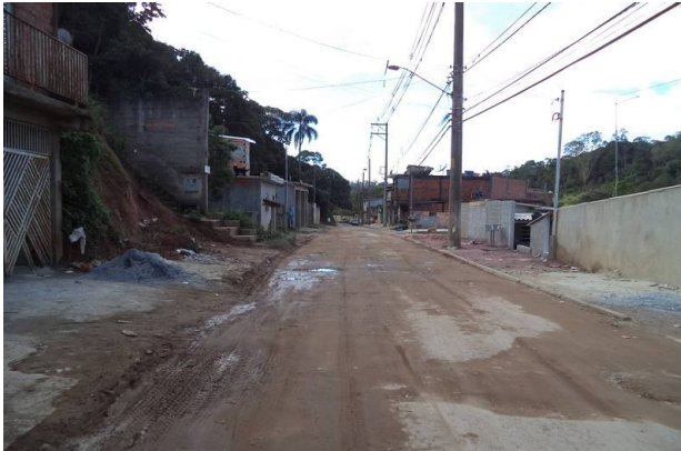
Vista da rua próxima a estaca 25, com direção a próxima estaca.
