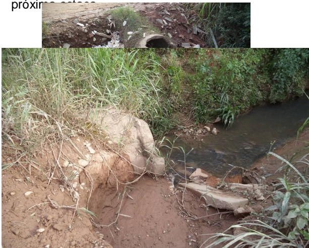
Bueiro existente próximo a estaca 39+8,50.
