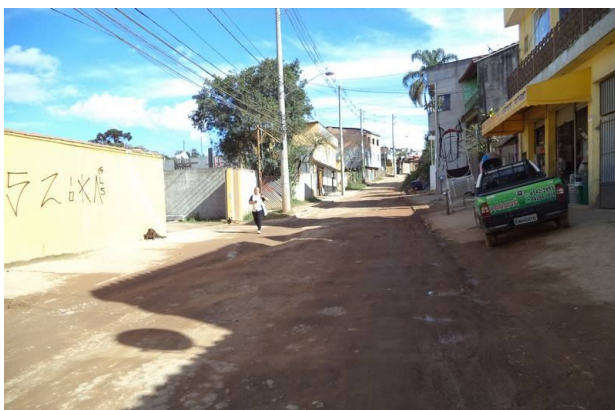
Vista da rua próxima a estaca 15, com direção a próxima estaca.
