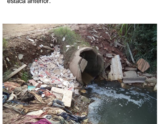
Bueiro existente próximo a estaca 39+8,50.
