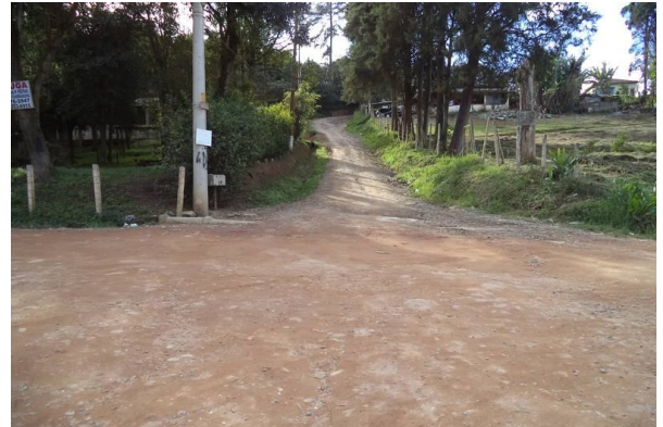
Vista da rua próxima a estaca 42, com direção a Estrada do Carneiro.
