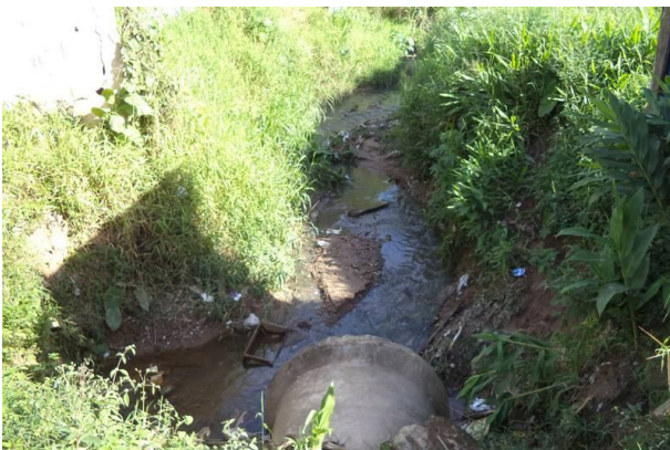
Bueiro existente na rua Roteldamo Bonini.
