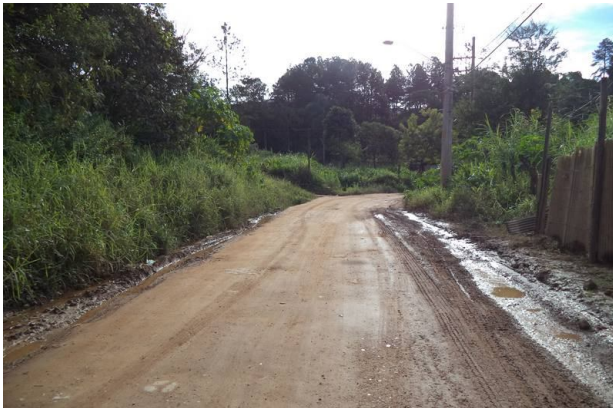
Vista da rua próxima a estaca 36, com direção a próxima estaca.
