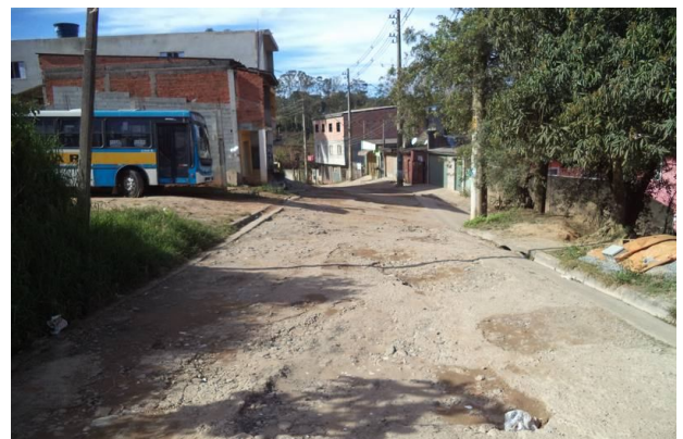
Vista da rua próxima a estaca 9, com direção a próxima estaca.
