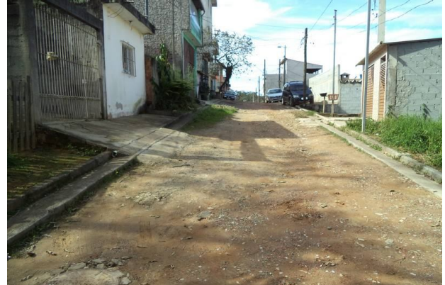
Vista da rua próxima a estaca 1, com direção a próxima estaca.
