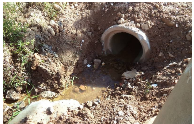
Bueiro existente na rua Roteldamo Bonini.
