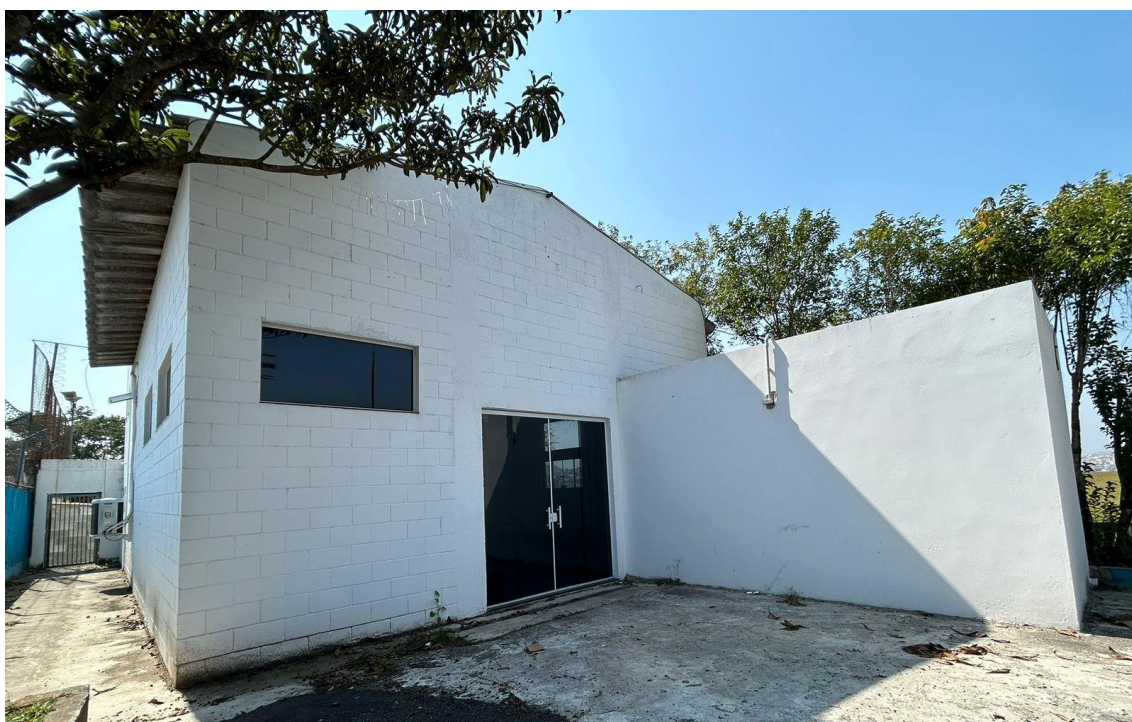
Prédio Administrativo Face Oeste - À direita da sala de equipamentos de onde deverá partir o cabo de fibra ótica.
