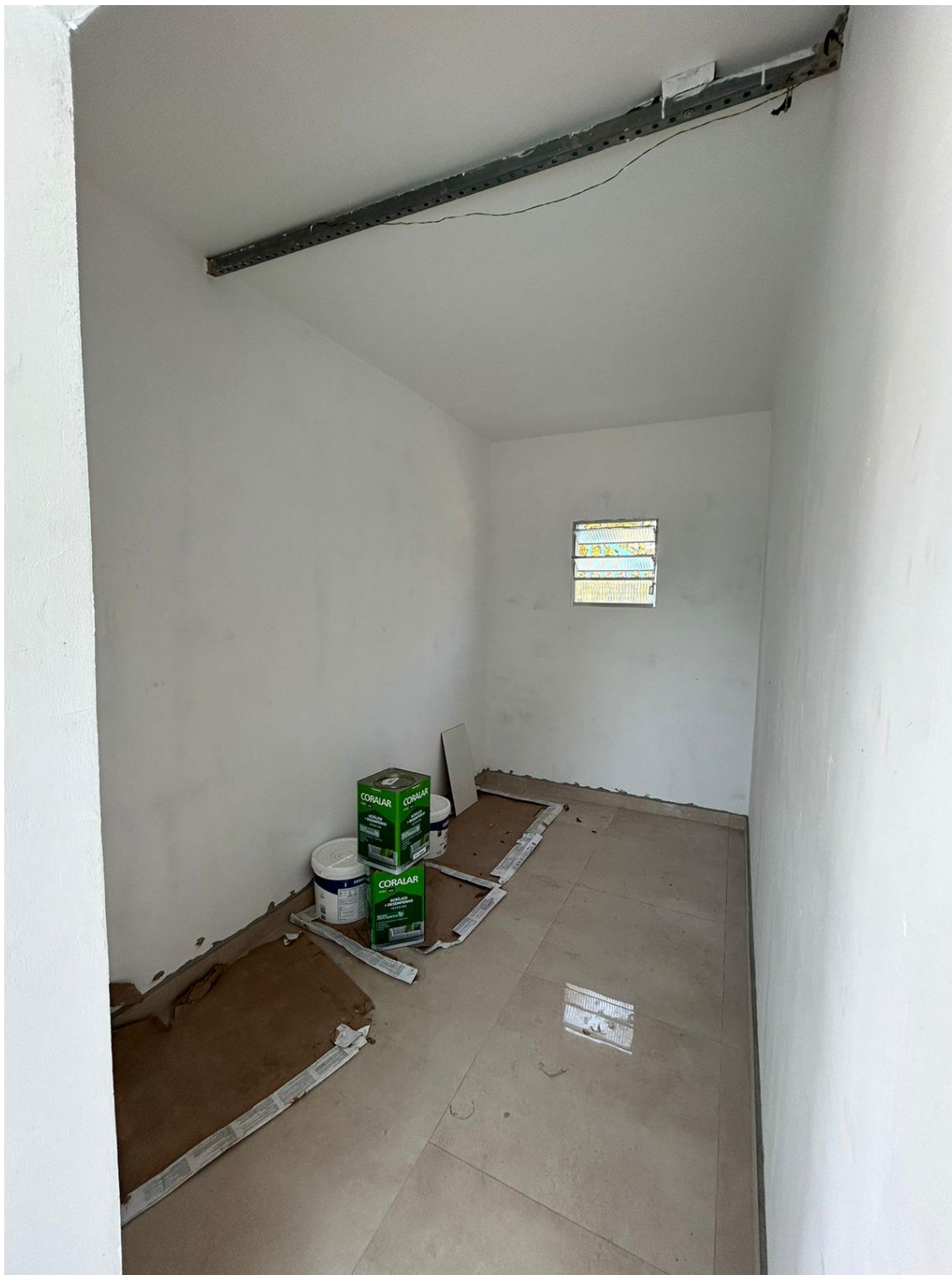
Prédio Superintendência - Sala da Diretoria de Fiscalização.
