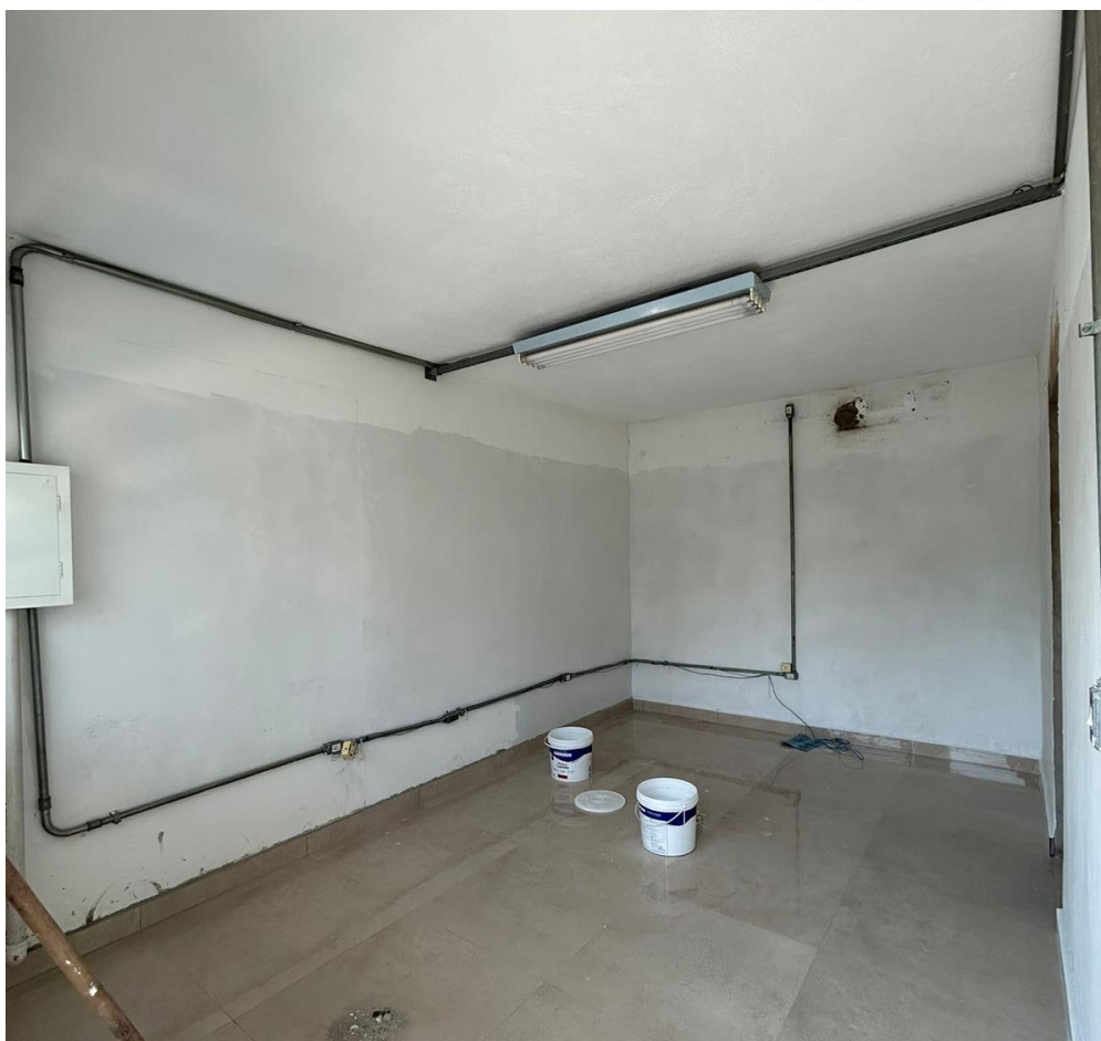
Prédio Superintendência - Sala de Superintendência.
