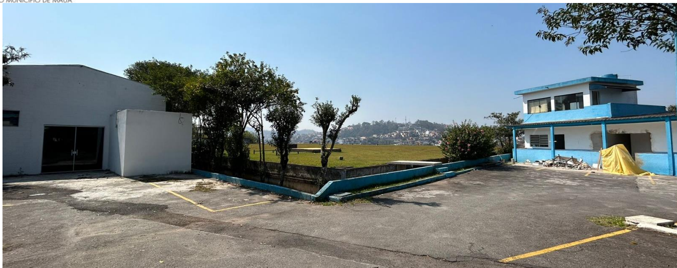
Vista do terreno com os dois prédios (Administrativo à esquerda e Superintendência à direita) que deverão ser interligados através de cabo de fibra ótica.
