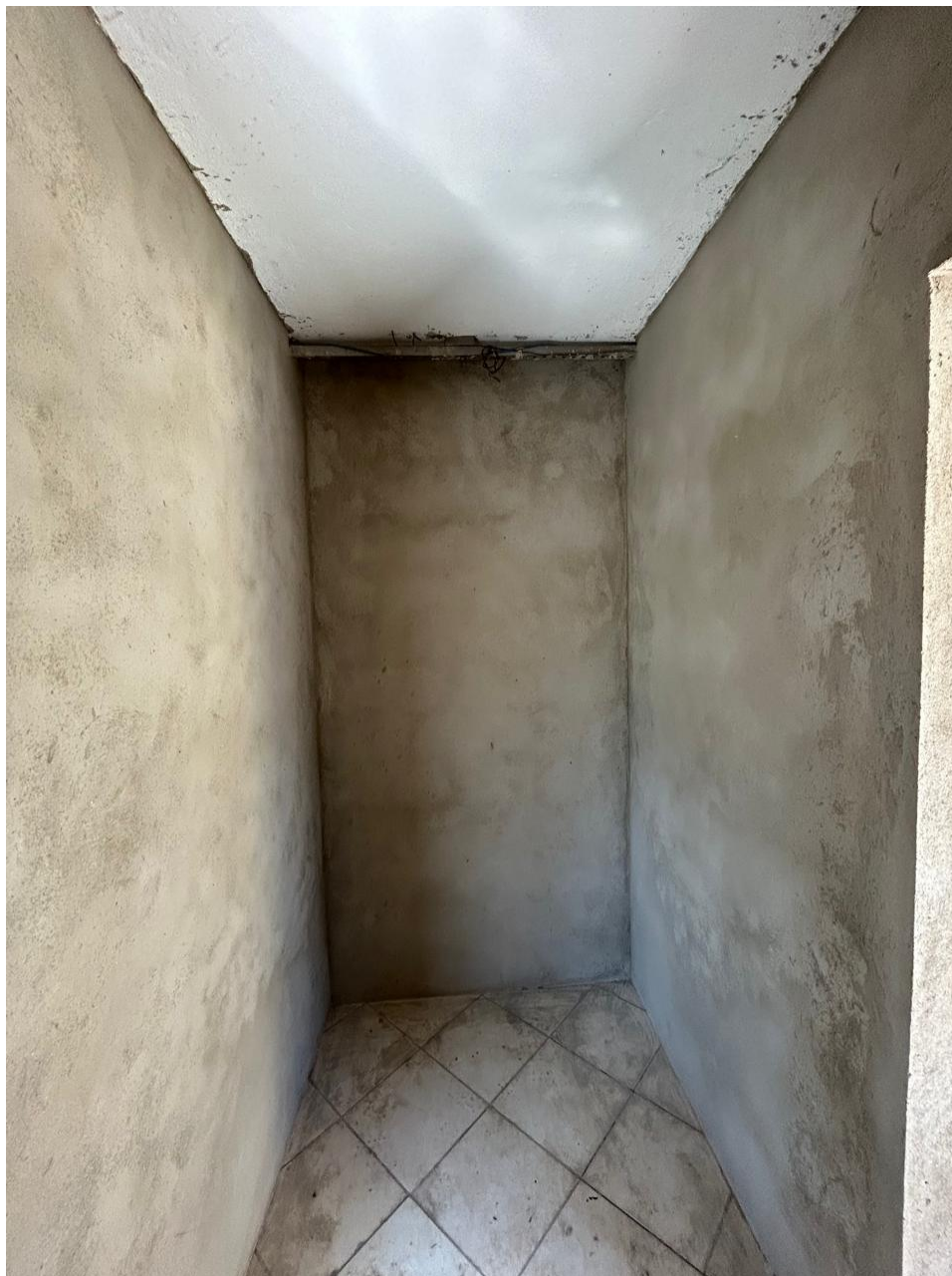
Prédio Superintendência - Localização para instalação o rack da rede de dados (recuo entre a sala de Superintendência e a sala de Assessoria).
