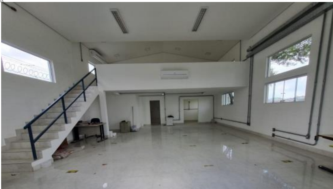
Vista do prédio a partir da porta de entrada.
