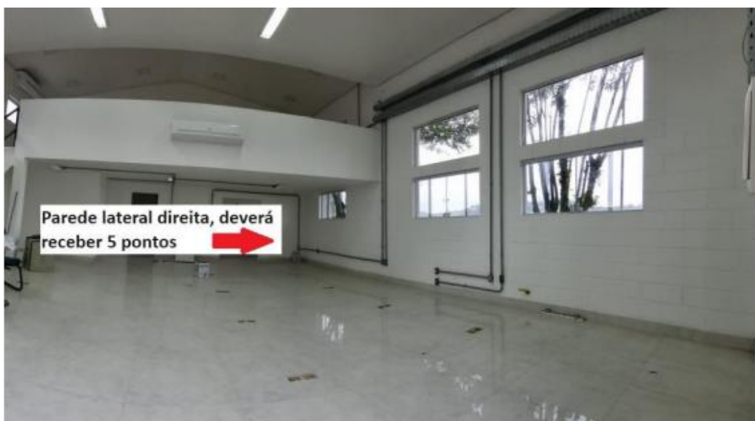
Vista da parede lateral direita
