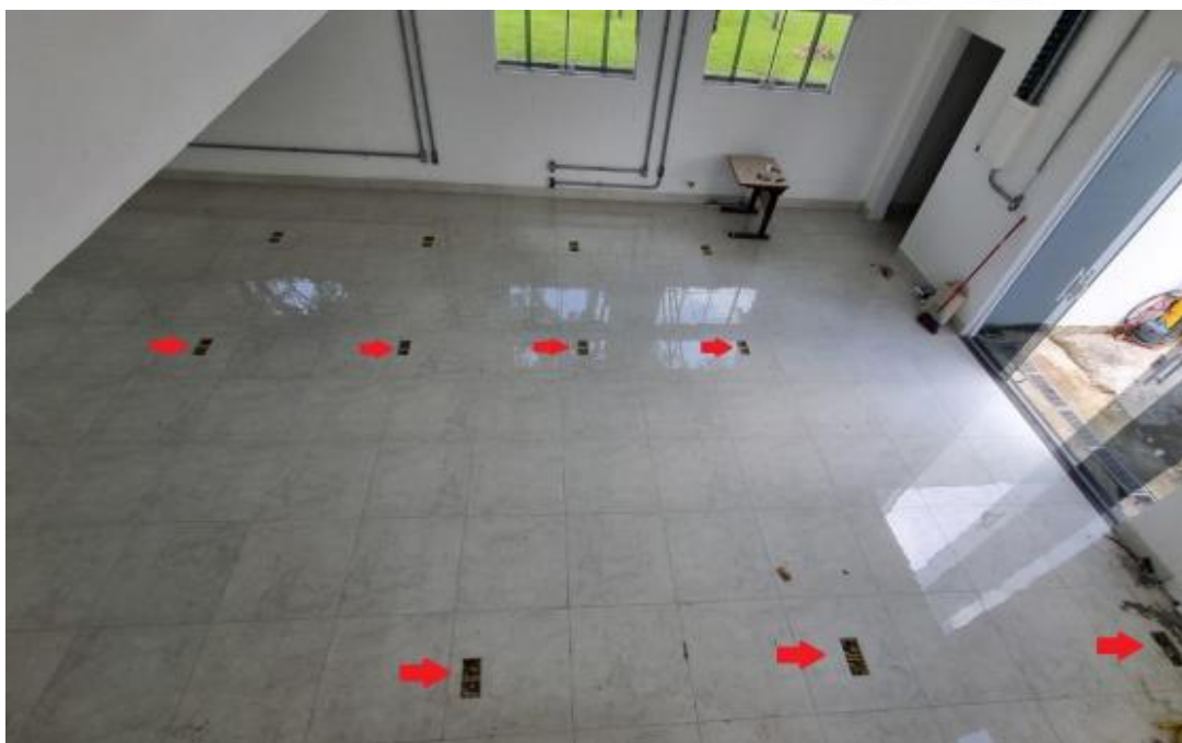
Vista dos pontos de piso.
