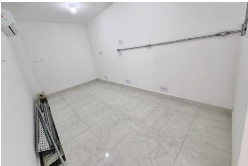
Sala de Datacenter, vista a partir da porta.
