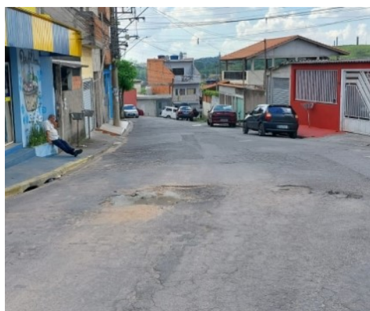
Figura 4 - rua Rio de Janeiro
