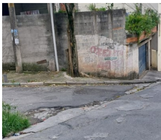
Figura 6 - rua Rio de Janeiro
