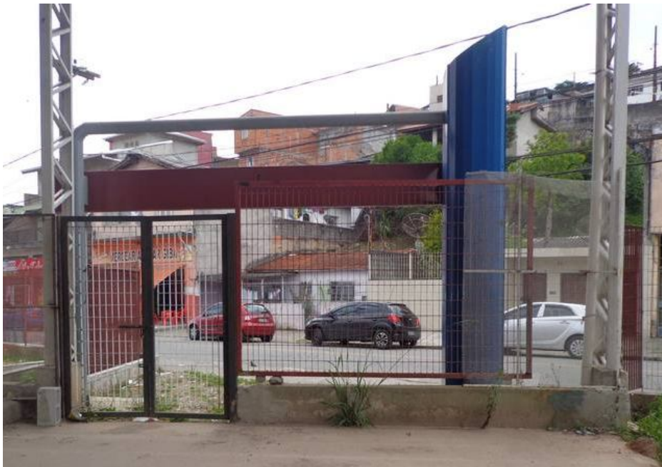
Imagem 01 – Pórtico instalado na entrada da unidade
