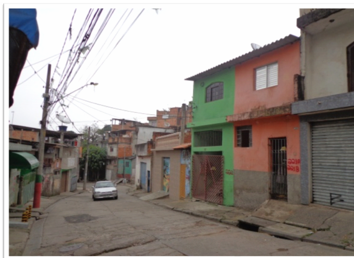
Rua Antonieta Monteiro Hauck – junho de 2013
