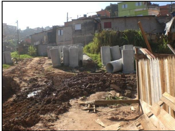
Foto 17 – Implantação de sistema de drenagem, na ocasião da implantação do sistema viário
