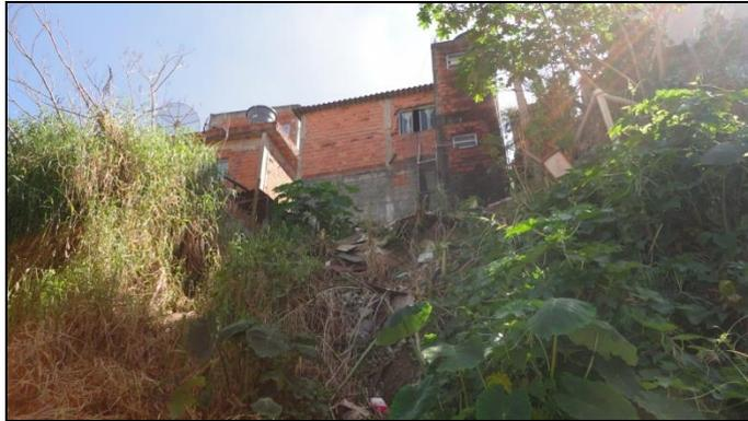
Foto 22 – Detalhe de erosão superficial do terrapleno e da proximidade da construção com a crista do talude instável
