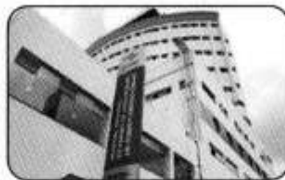
HOSPITAL REGIONAL DE FERRAZ DE VASCONCELOS
