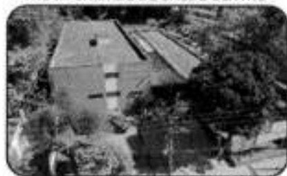
Local onde será construída a nova UBS
