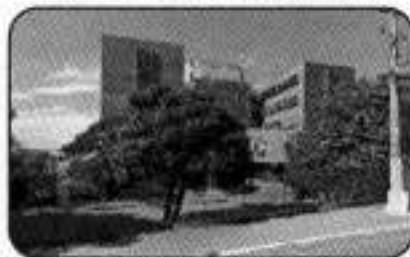
HOSPITAL GERAL DE GUAIANASES
